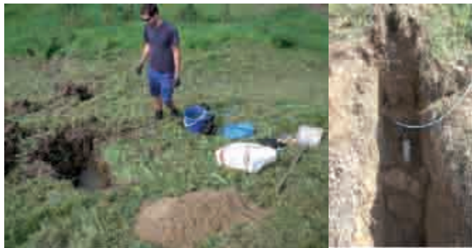
Obrázek 6. Instalace piezometrických čidel do předem připravené šachty v místě průsaku
