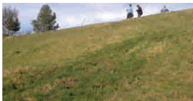
Obrázek 4. Pohled na vzdušný líc hráze s patrným místem průsaku podle intenzivnějšího travního porostu
