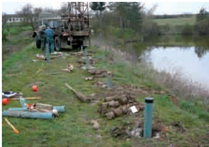
Obrázek 7. Hloubení injekčních vrtů pro následnou aplikaci směsi Nutrolase
