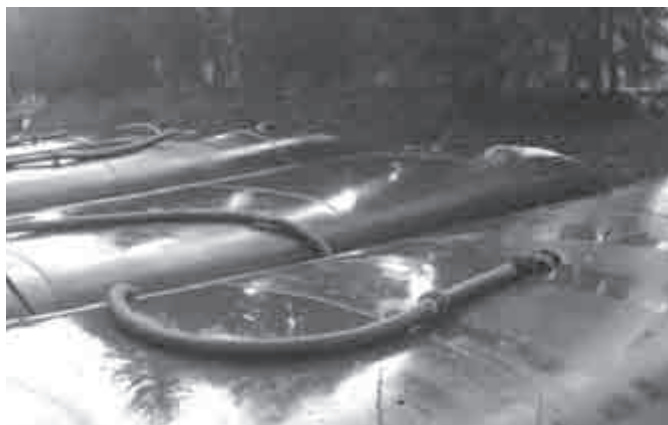
Obrázek 7. Sediment byl průběžně čerpán do naplněných vaků (uvnitř byl přetlak vůči okolí)
