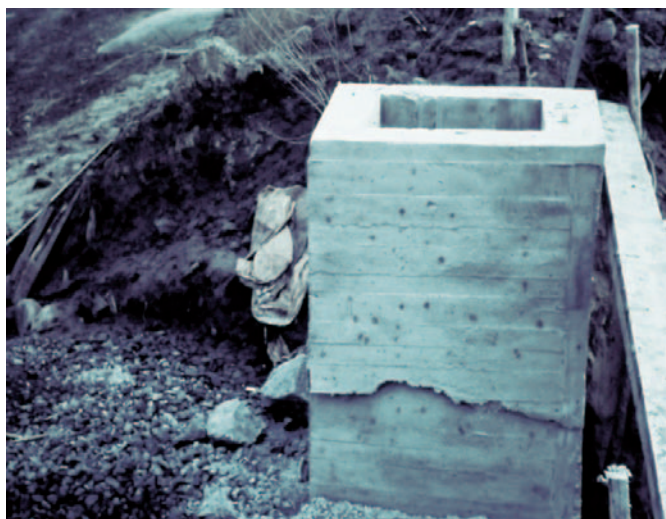
Obrázek 6. Přetok betonu – otevřená průsaková cesta po sednutí násypu.
