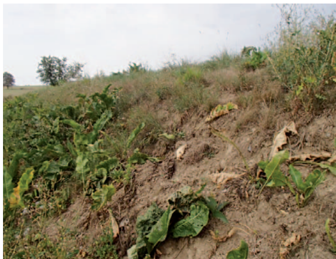
Obrázek 21. Rozkopaný svah hráze - vyhledávání kořene křenu.
