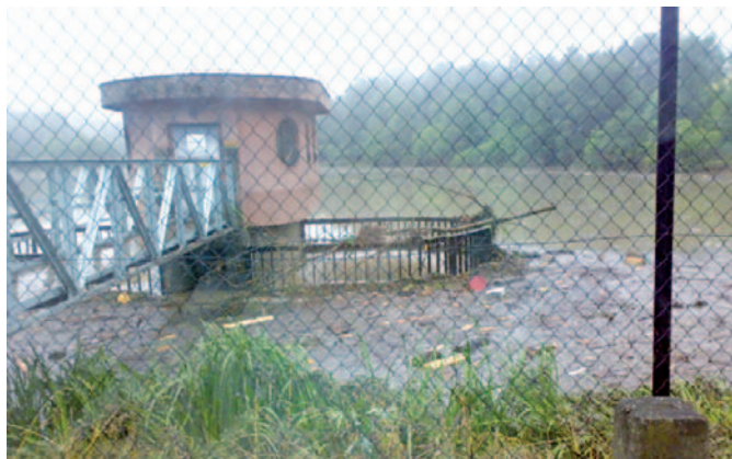
Obrázek 9. Nevhodně umístěné česle u přelivné hrany šachtového přelivu.
