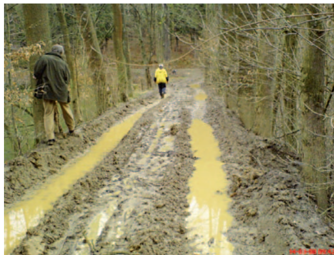
Obrázek 22. Lesní technikou rozježděná koruna hráze.
