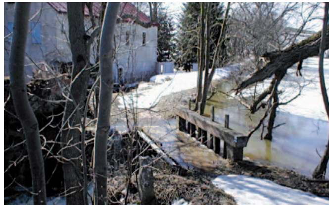
Obrázek 12. Nemanipulovatelné tabule, obtékání po obou stranách objektu.
