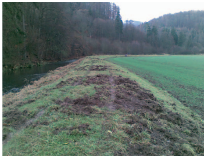
Obrázek 20. Porušené travní opevnění hrází rozrytím divokým prasetem.
