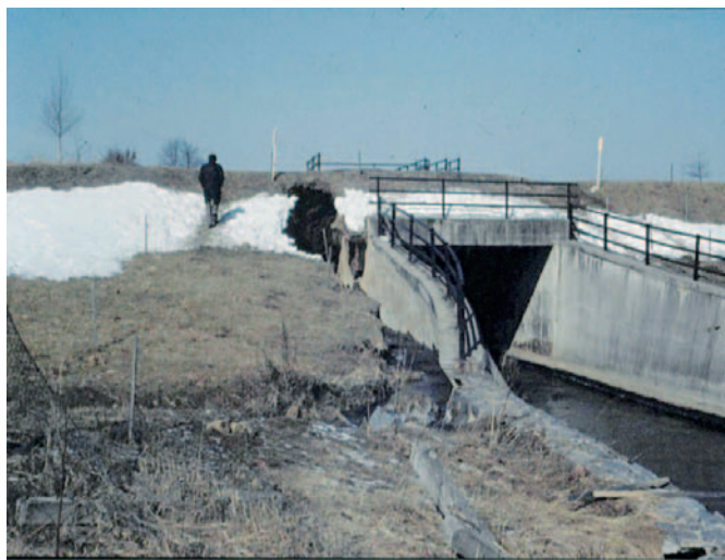
Obrázek 8. Trhlina kolem zdi objektu – nedodržen projekt – chybí žebro zeď je svislá.
