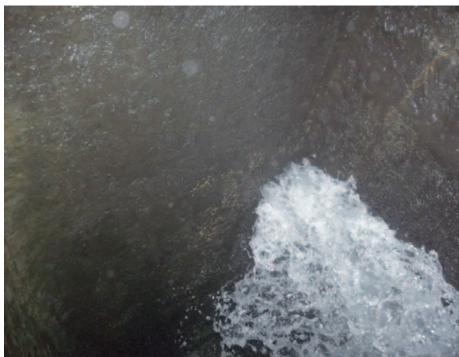
Obrázek 5. Trhlina ve stěně požeráku, špatná kvalita betonu, neošetřená pracovní spára.
