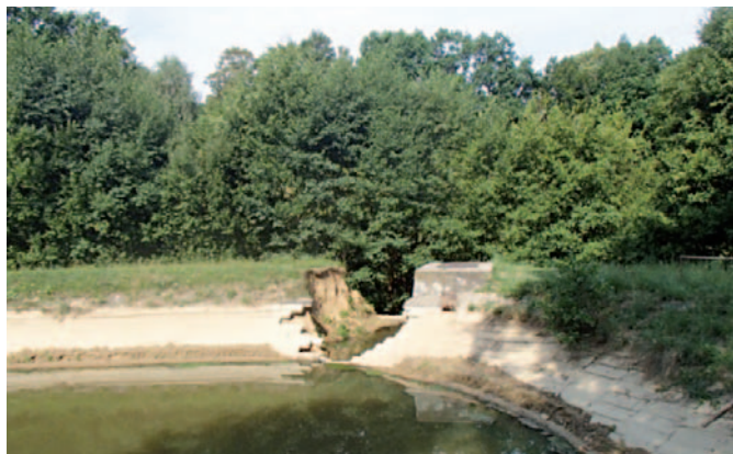
Obrázek 13. Protržená hráz boční nádrže po přelitu při povodni.
