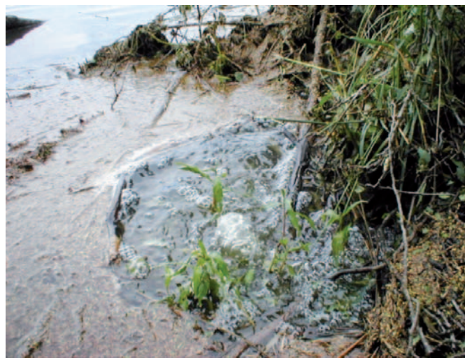
Obrázek 16. Výron bublin ze vznikající poruchy potrubí na návodní straně u požeráku.
