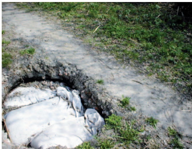
Obrázek 19. Propad hráze při povodni v místě bobří nory.
