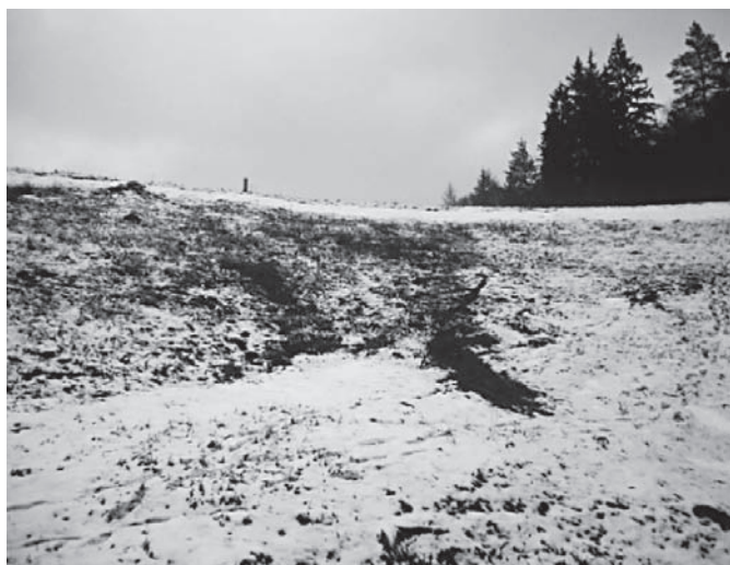
Obrázek 3. Zamokření vzdušného svahu po vyvinutí otevřené průsakové cesty.
