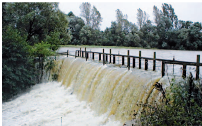
Obrázek 11. Neprovedení manipulace tabulemi - nouzový přeliv v zavázání.
