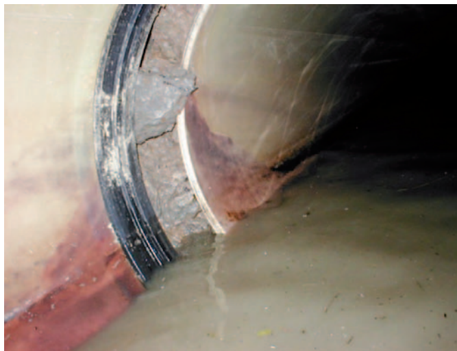
Obrázek 1. Rozpojené potrubí po deformaci způsobené sedáním násypu hráze.
