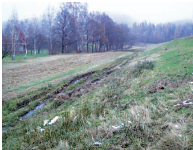
Obrázek 4. Průsaky nad bermou – otevřená cesta ve vrstvě z nevhodného materiálu.
