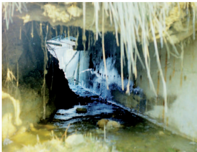
Obrázek 7. Trhlina kolem bezpečnostního přelivu – chybí zavazovací žebro.
