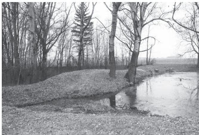
Obrázek 4. Vodní dílo Svěsedlice – nerovná niveleta hráze, vzrostlé stromy na hrázi.
