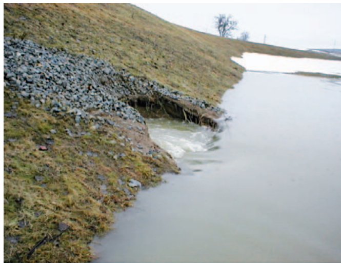
Obrázek 2. Porucha vytvořená po odplavení materiálu z okolí otevřeného spoje.
