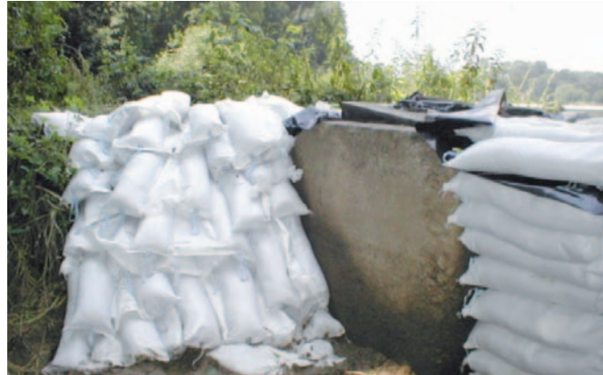
Obrázek 14. Provizorní zahrazení a utěsnění nádrže hráze rybníka na obtoku po přelitu.
