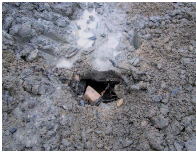
Obrázek 15. Porušený styk dřevěného potrubí a betonového potrubí.
