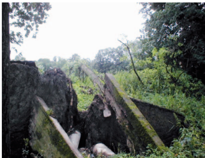
Obrázek 17. Potrubí spodní výpusti poškozené vývratem topolu.
