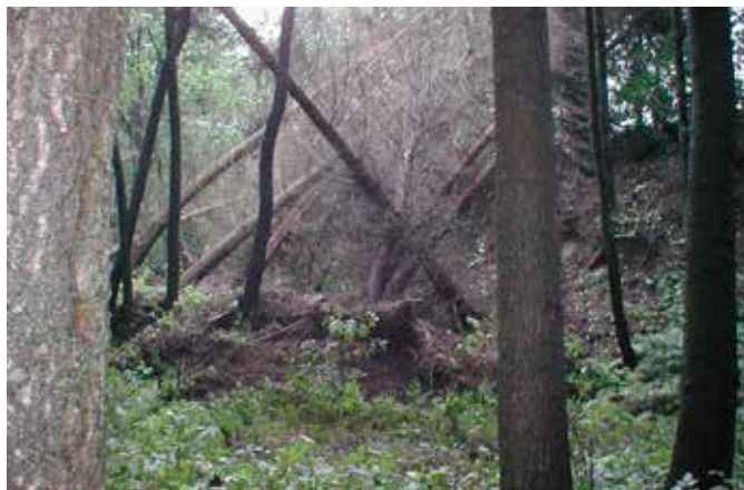
Obrázek 12. Vývrat smrků na vzdušném svahu hráze
