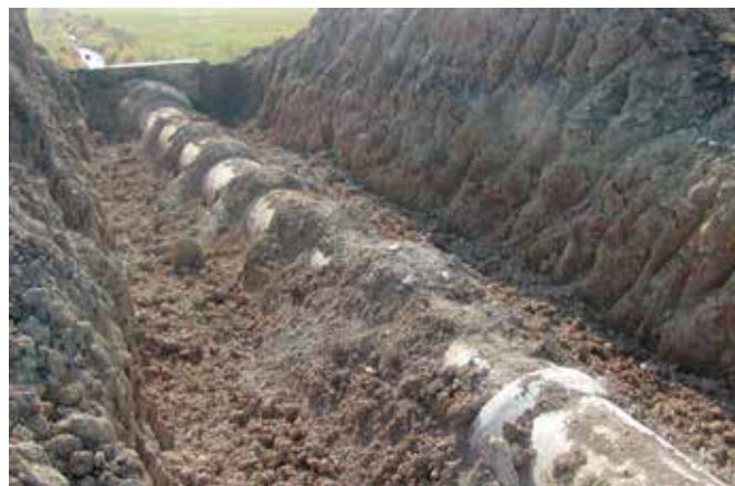
Obrázek 6. Špatně obetonované potrubí spodní výpusti
