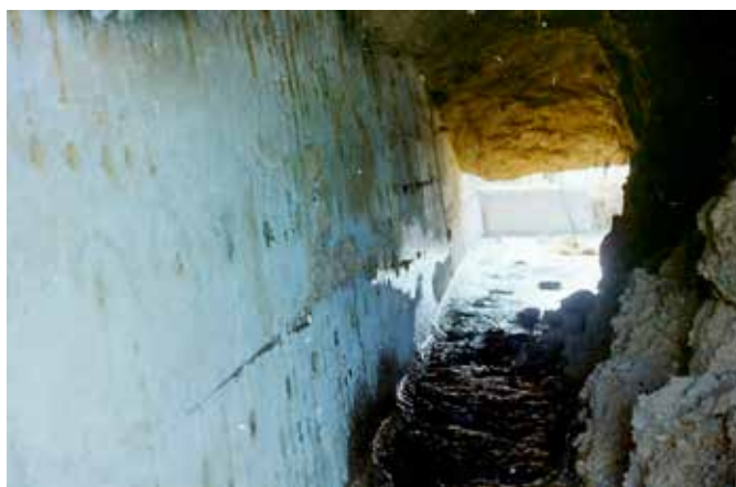
Obrázek 4. Porušení hráze po silných mrazech a následném tání při absenci žebra
