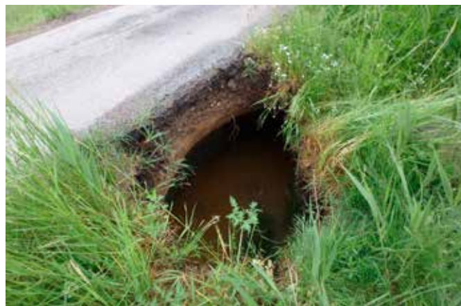
Obrázek 10. Propad kaverny na návodní straně hráze
