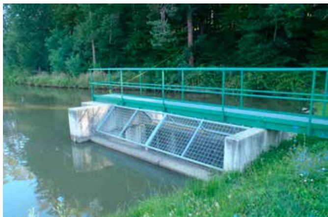
Obrázek 9. Mříže na bezpečnostním přelivu
