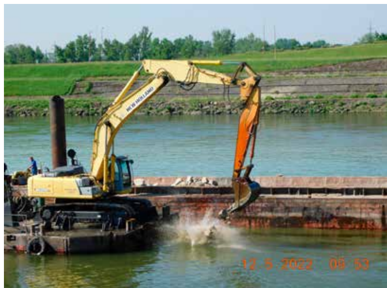
Obr. č. 4 Ukladanie lomového kameňa do výmoľu č. 1
