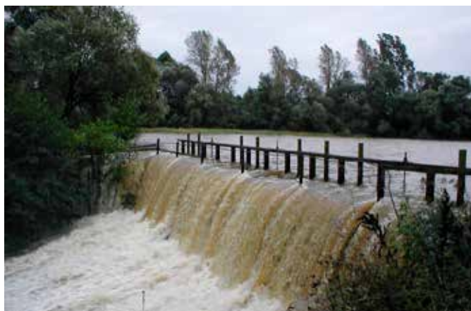
Obrázek 8. Hrazený přeliv, při povodni nevyhrazený
