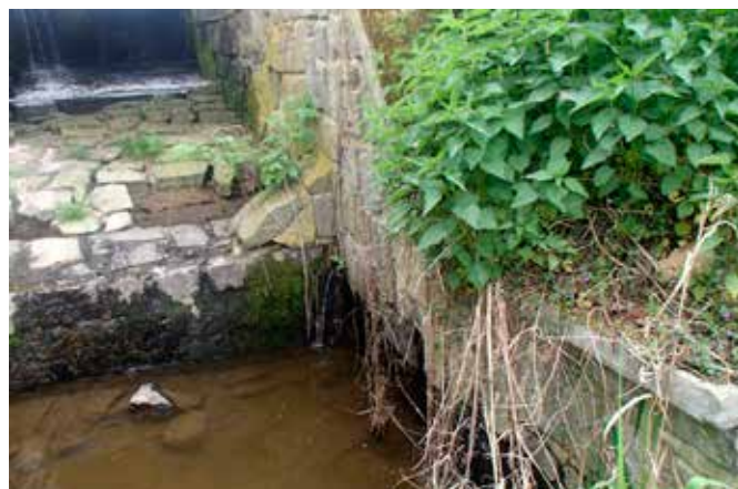
Obrázek 11. Rozpad kamenného zdiva skluzu a zdi
