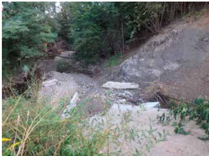
Obrázek 3. Odplavené opevnění skluzu a sesuv pravého svahu
