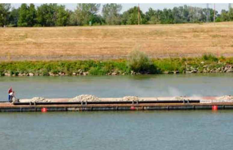
Obr. č.3 Zásyp výmoľov makadamom dno výsypným člnom
