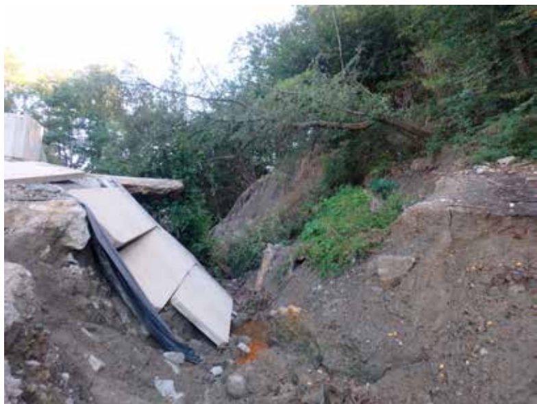
Obrázek 2. Protržení hráze v místě bezpečnostního přelivu
