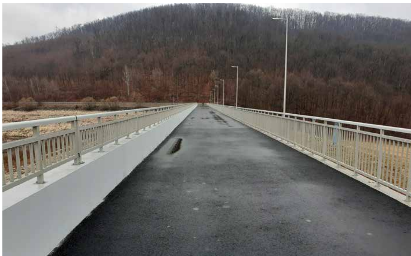
Obrázok 3. Koruna hrádze po oprave
