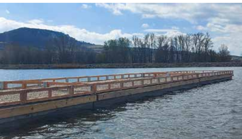
Obrázek 3. Vlnolam na hladině Střední nádrže
