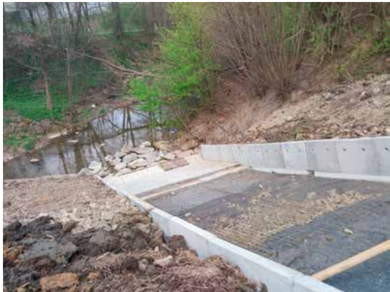
Obrázek 1. Skluz bezpečnostního přelivu – výstavba 2019
