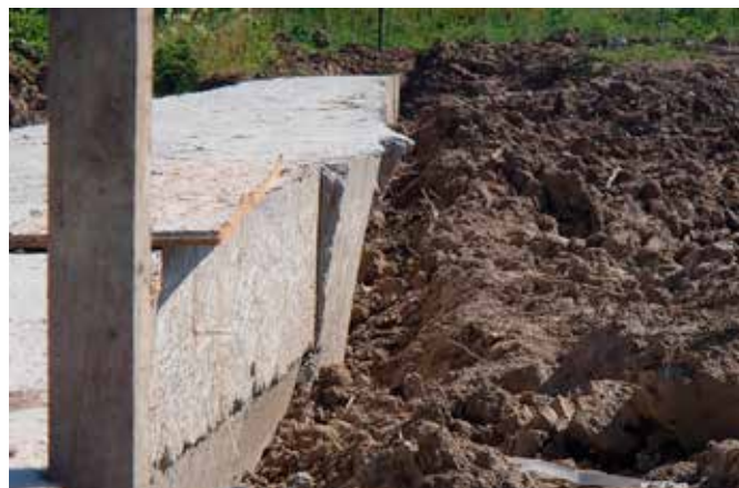
Obrázek 7. Špatně provedené bednění, přetoky betonu
