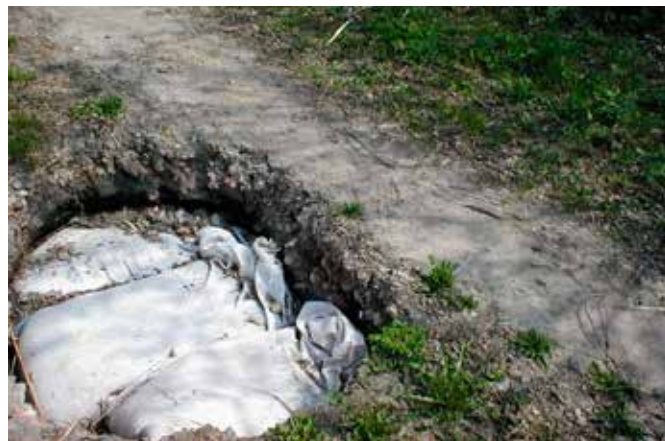
Obrázek 13. Provizorně sanovaná bobří nora po propadu koruny hráze
